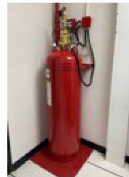
ระบบดับเพลิงชนิด Novac
