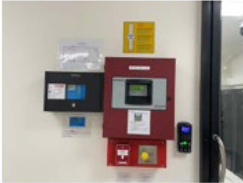
PLC ควบคุมแอร์
